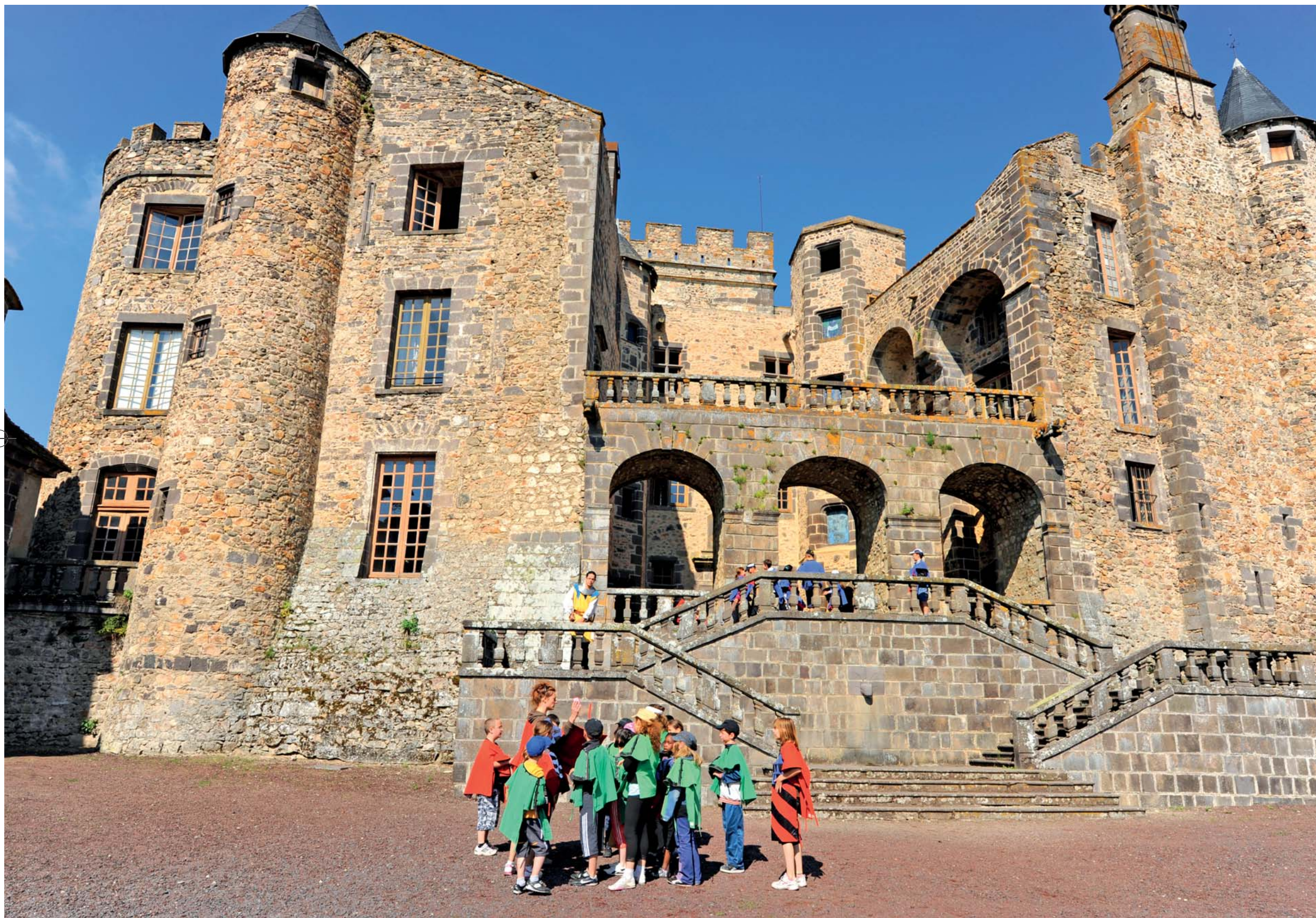
■ CHÂTEAU DE CHAZERON (LOUBEYRAT, PUY-DE-DÔME). La seule réalité de ce château, affirme sans état d'âme son propriétaire Raphaël Bruny, « est de le transformer en commerce touristique, en prenant garde de ne pas dénaturer les lieux. Sauf que je suis architecte, et pas professionnel du tourisme ».
